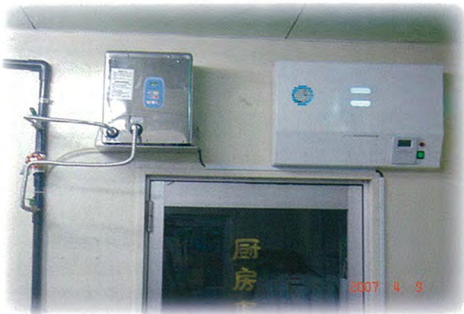
厨房下処理室
